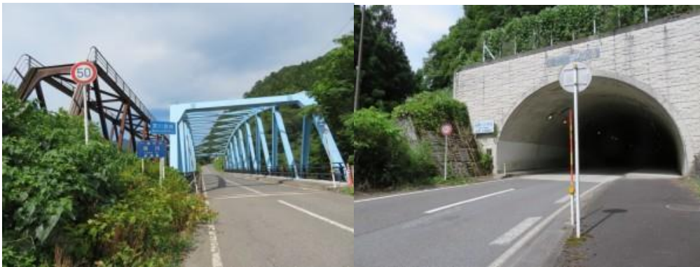
※実川島橋、当麻トンネル
